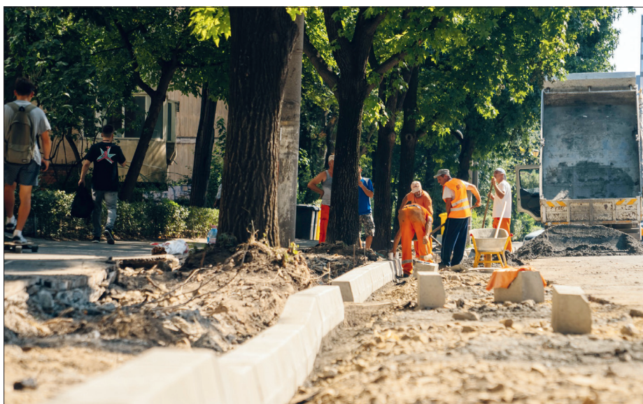
Lucrări în desfășurare pe Calea Circumvalațiunii
