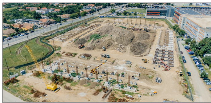
Lucrările la noul stadion avansează în ritm susținut
