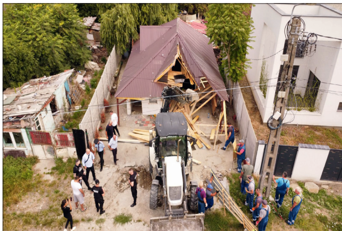
Casa și anexele, construite fără autorizație pe terenul public, au fost demolate
