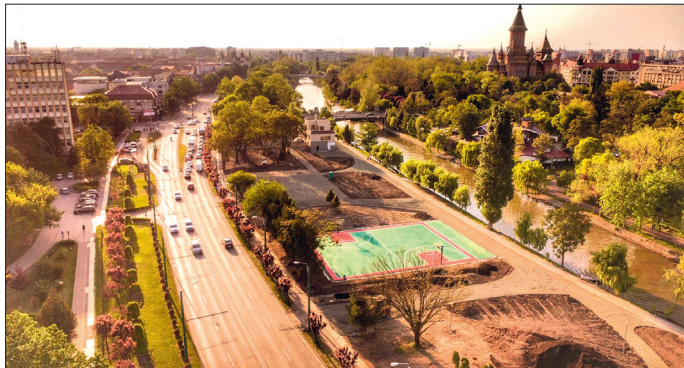
Malul Begăi după demolarea construcțiilor ilegale și începerea lucrărilor de amenajare a zonei
