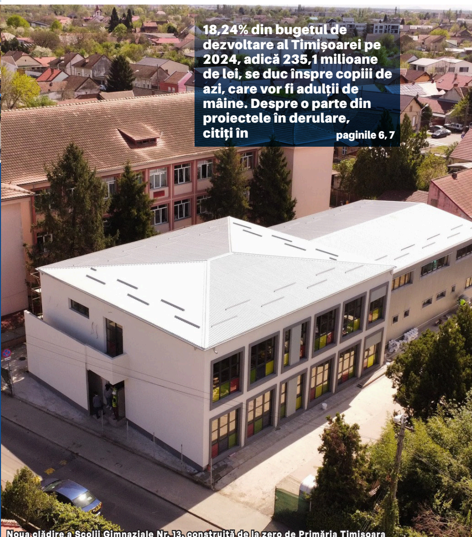
Noua clădire a Școlii Gimnaziale Nr. 13, construită de la zero de Primăria Timișoara
