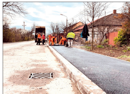
Ultimele lucrări de pe strada Câmpului
