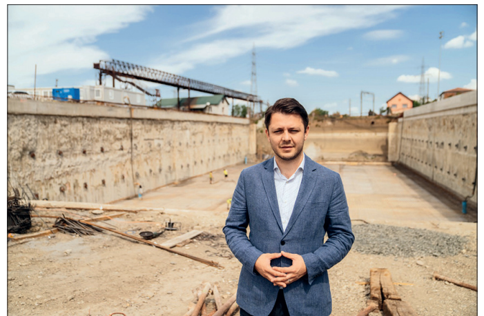
Viceprimarul Timișoarei, Ruben Lațcău, în vizită de lucru pe șantierul pasajului Solventul
