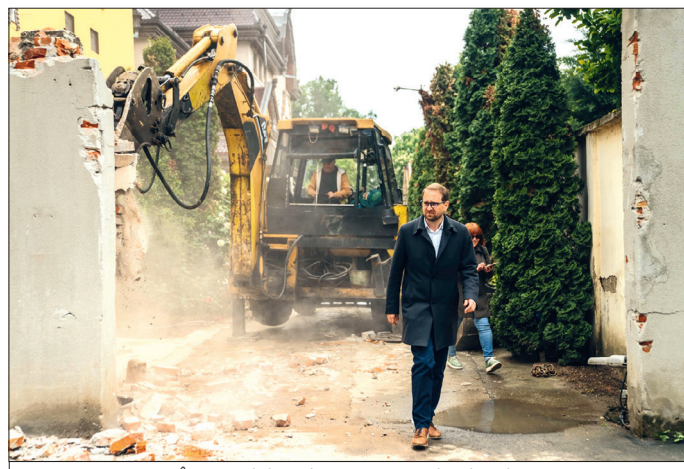
În timpul demolării construcțiilor ilegale
